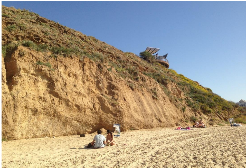
איור 1: מצוק חוף אשקלון
